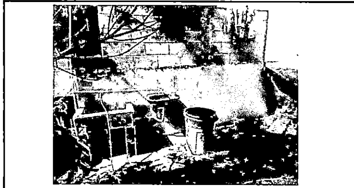
Foto 3: Lavamanos en mal estado
